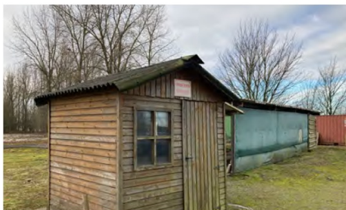
14 - chalet waar batterijen worden opgeladen
